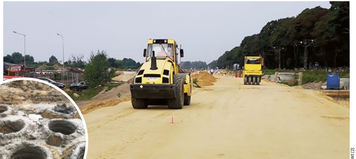
Rozpoczęła się budowa nowego torowiska w ciągu ul. Kosmonautów. Na plac budowy wjechała palownica, która drąży specjalne otwory
