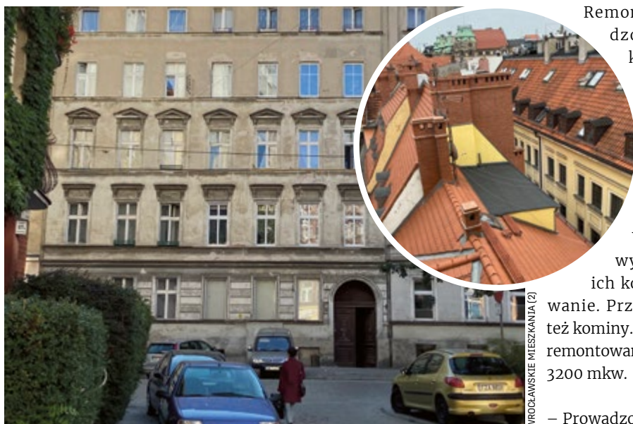
Ulica Sępa-Szarzyńskiego: tutaj w 6 kamienicach naprawią dachy
